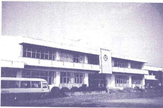
▲青く広い空の下の作業所です。
